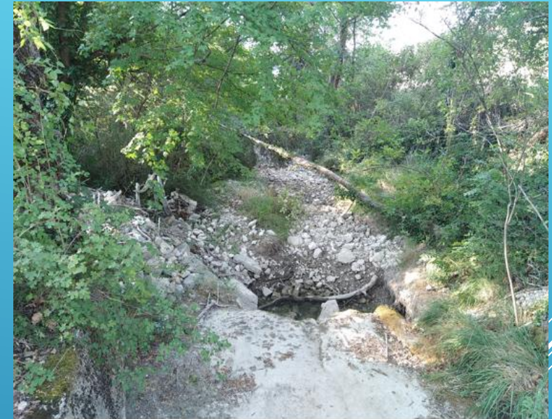
Avant et après intervention
