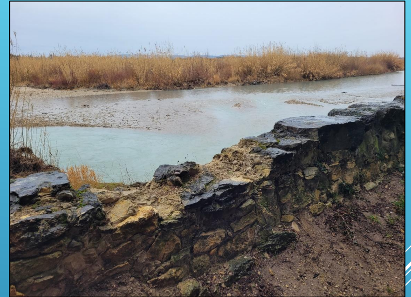
Avant et après intervention
