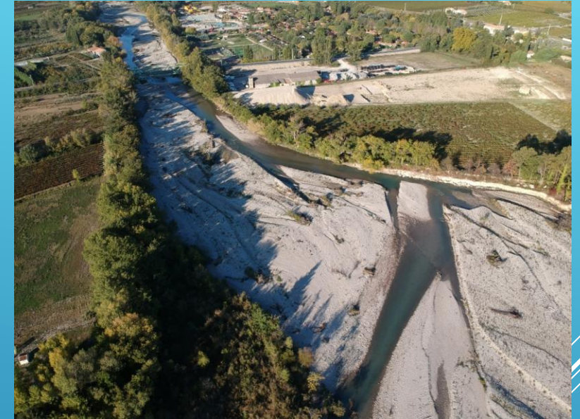
Avant et Après intervention
