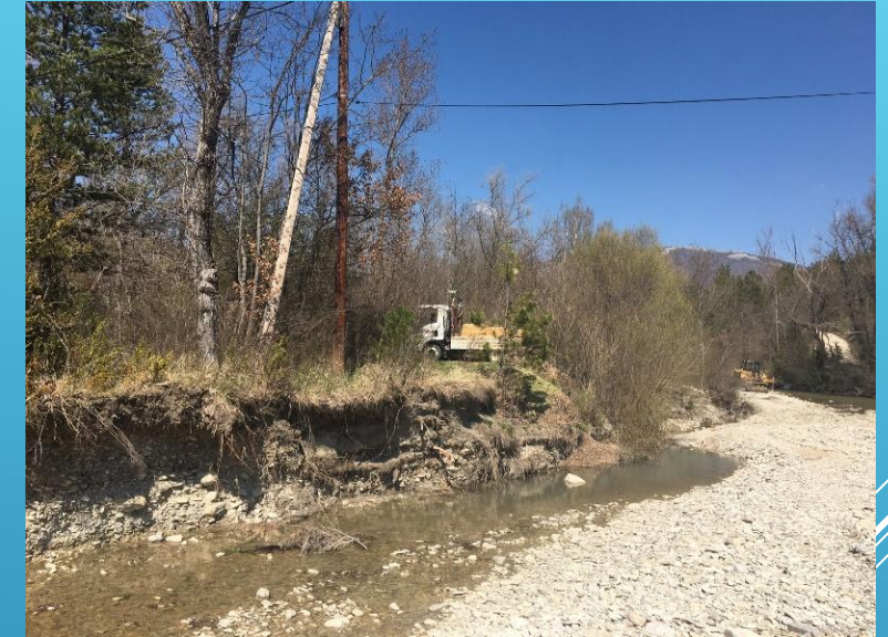
Avant et après intervention
