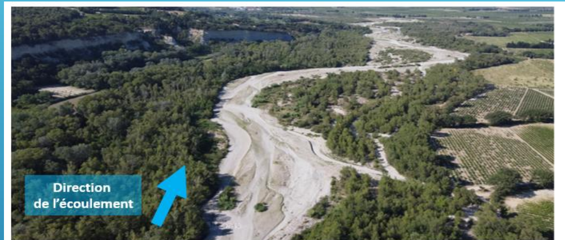
Avant et après intervention
