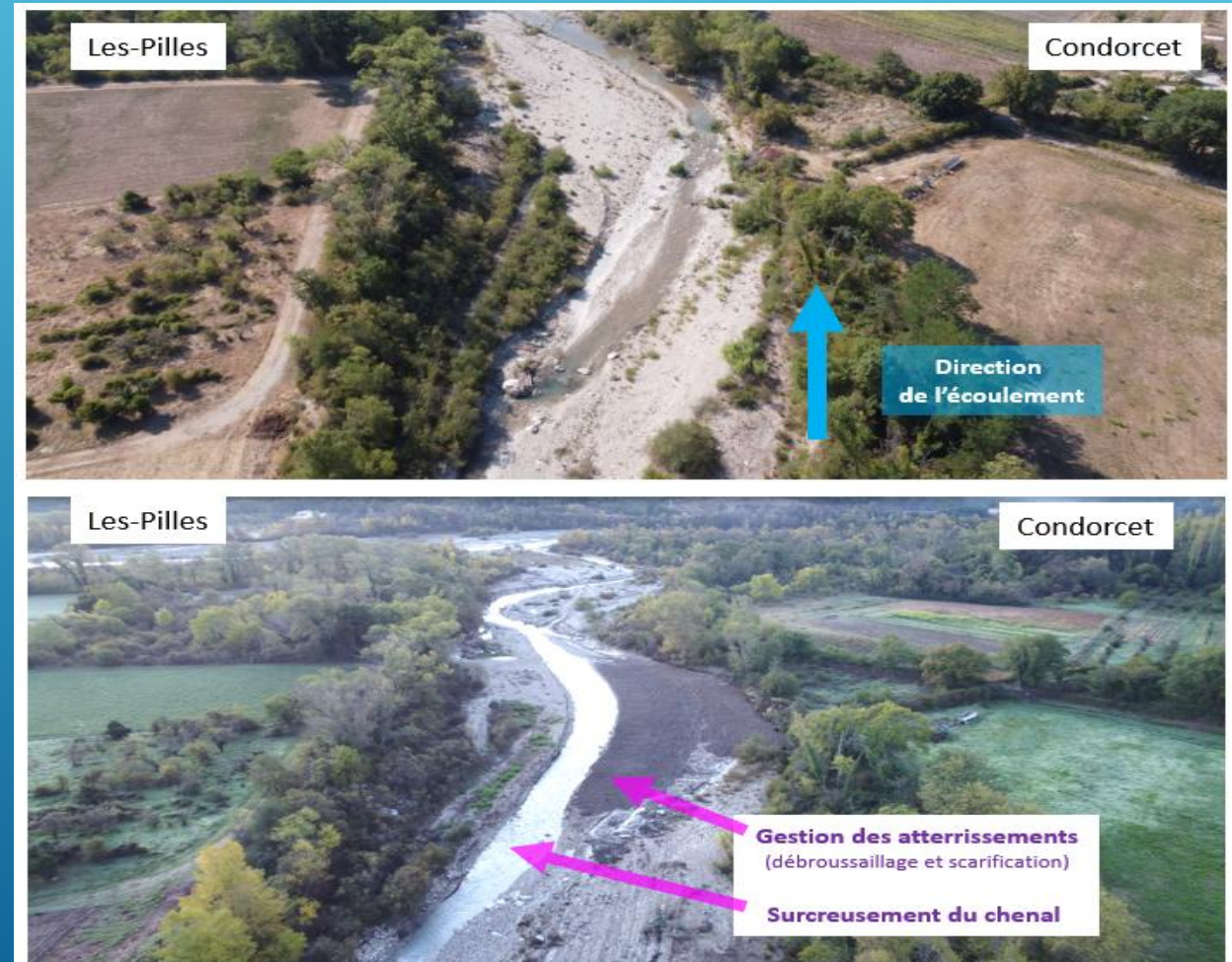
Avant et après intervention
